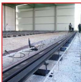
In bestehenden Hallen wird nach Bodenprüfung eine entsprechende Verlegeart gewählt. Dafür wird die Fläche für den Schienenbereich z.B. ausgefräst oder auf den vorhandenen Boden aufgebracht.
