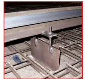
Eine Art des Schienenaufbaus ist die Verlegung auf Streifenfundament im Neubau.
