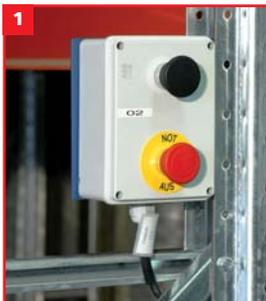
NOT-AUS-Schalter / Bedientaster an jedem Fahrwagen
