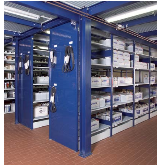
Batterielagerung in Umweltregalen mit Wannböden
