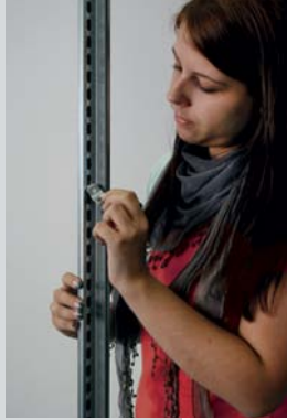
Schritt 2: Fachbodenträger einhängen
