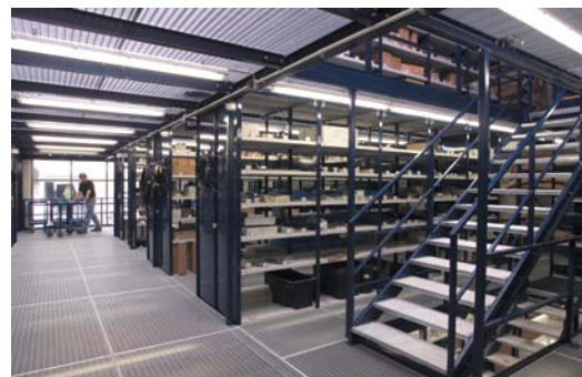
Das ca. 1.250 m² große dreigeschossige Logistikcenter bietet viel Stauraum
