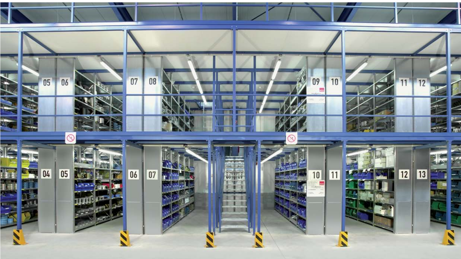
Bei diesem Regionalversorger wurde eine 5,65 m hohe dreigeschossige META CLIP® Fachbodenregalanlage mit über 1600 Fachböden errichtet
